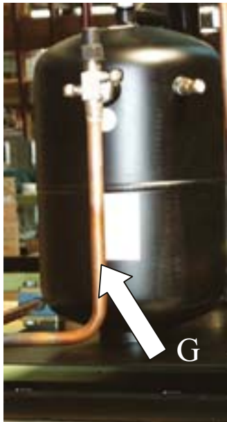
Рис. 8/4 Соединения компрессии (H) и возврата (G) от конденсатора для UCR с герметическими компрессорами Copeland
